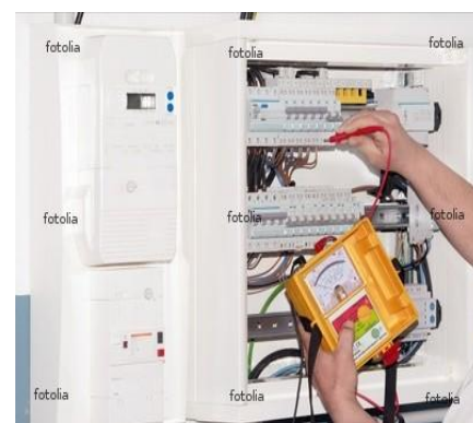
Contrôle du tableau électrique
